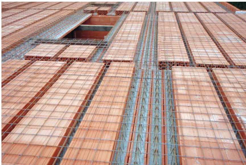
Montáž těžkého stropu Heluz.
