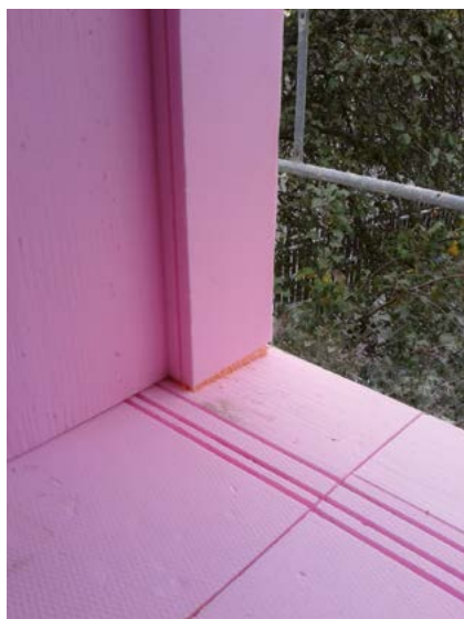
Předpřipravený stavební otvor pro okno z extrudovaného polystyrénu s chráněnou připojovací spárou. Řešení na principu špaletového kastlíku HELLA TRAV ® frame.
