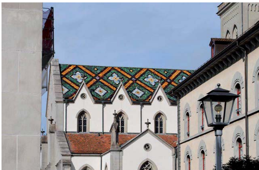
Novogotický kostel chrám sv. Vavřince (Laurenzen, Lawrence) v městě St. Gallen (Švýcarsko) má střechu chrámové lodi porytou mozaikou z barevných glazovaných pálených střešních tašek kladených na koso.
