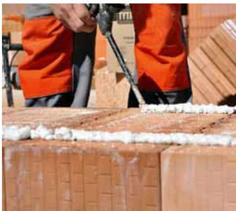
Speciální pěna (bezcementové tenkovrstvé lepidlo) pro lepení přesně broušených cihel
